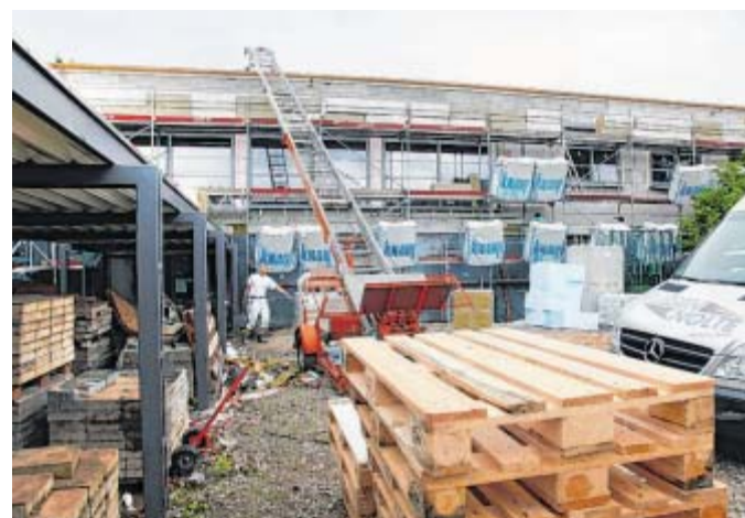
Soll in den Sommerferien fertiggestellt werden: Der Neubau für die Offene Ganztagschule und die Verwaltung der Grundschule Kaunitz.
